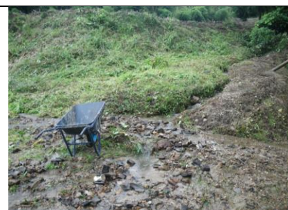
大雨で増水、地崩れで埋まった水路の復旧作業
