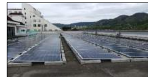
【県立ひょうごこころの医療センター:コンクリートブロック据置型】
