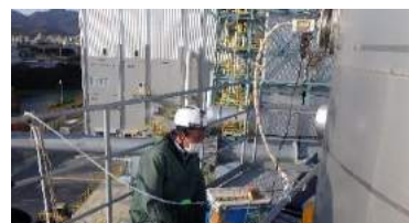
【バイオマス発電施設の排ガス調査】
