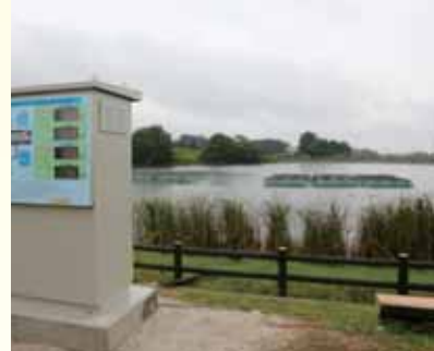
▲太陽光パネル
