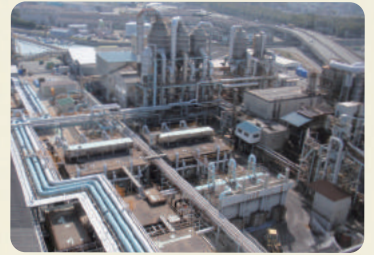
木質バイオマス発電設備
