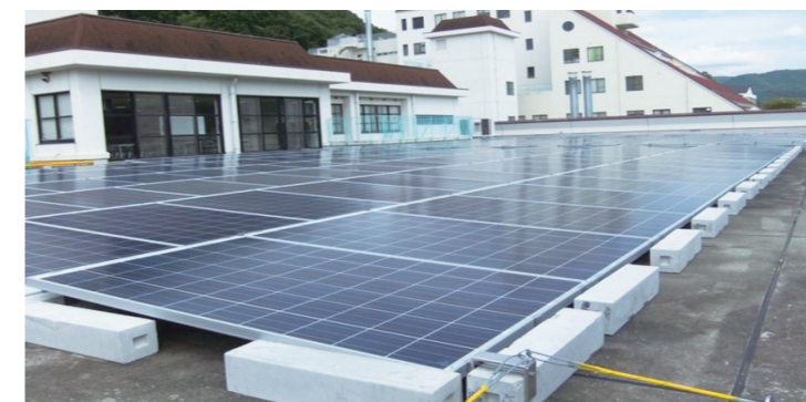
ひょうごこころの医療センター 発電規模:114.6kW (多結晶シリコンパネル 245W×468枚、コンクリートブロック据置型)
