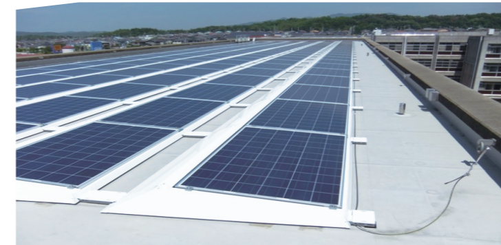
三木北高等学校 発電規模:101.2kW (多結晶シリコンパネル 240W×422枚、スチール枠据置型)
