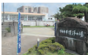
▲浄水場としては日本初(伊丹市調べ/給水人口5万人以上の浄水場)の、再生可能エネルギー100%の電力で稼働する千僧浄水場
