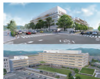
▲ZEB Ready認証を取得した伊丹市新庁舎(2022年秋竣工予定)。設置される太陽光発電と蓄電池は災害時の備えにも
