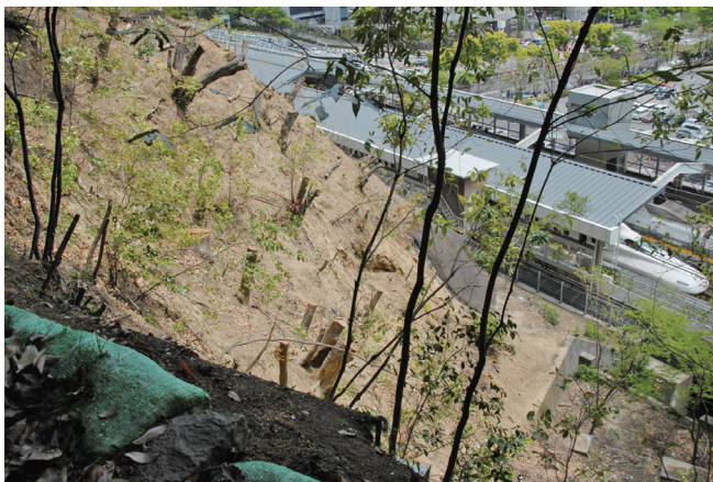
▲図2 新神戸駅北側斜面の急傾斜地における樹木の伐採状況 (2013年5月3日撮影)
