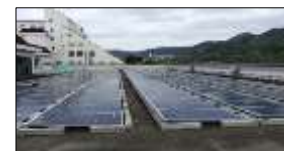
【県立ひょうごこころの医療センター:コンクリートブロック据置】
